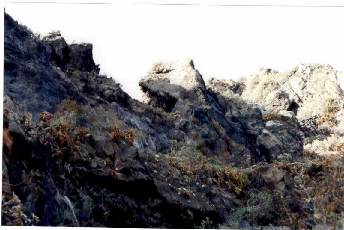
Fotografía nº 20: Bloques inestables en la colada 6.
