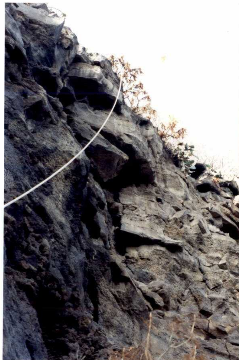
Fotografía nº 14: Bloque muy fracturados e inestables en la colada 5.
